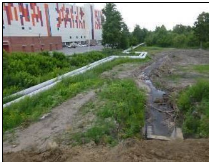
Рис. 28. Теплотрасса и выход стока ливневой канализации (26.06.2014 г.).
