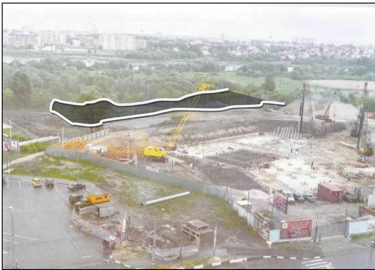
Рис. 14. Вид сверху на зону строительства и участок 2 (Июнь 2014 г.).
