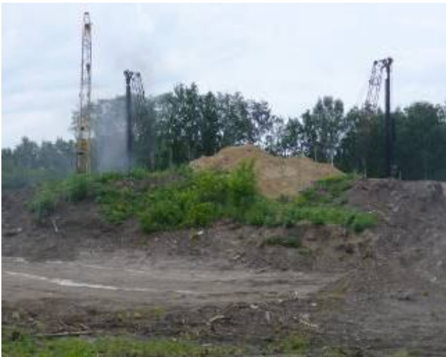
Рис. 17. Отвалы и насыпи грунта на участке 2 (26.06.2014 г.).
