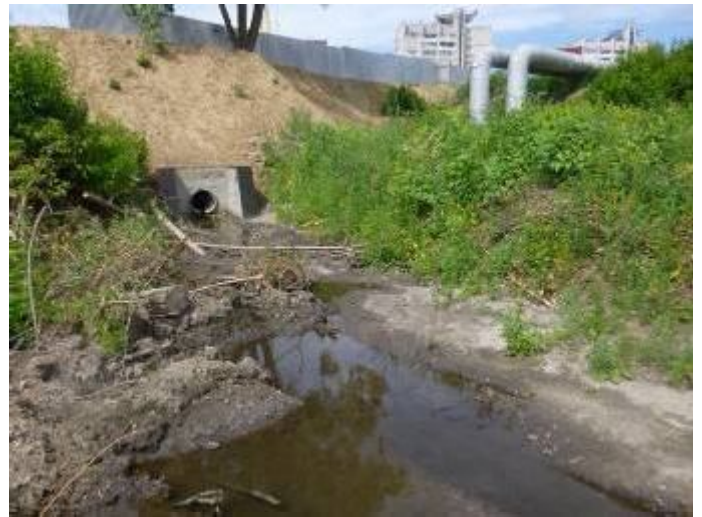
Рис. 18. Место выхода и сток ливневой канализации на участке 2 (26.06.2014 г.).
